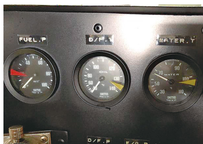
写真11 作動不良状態の油温計と水温計
