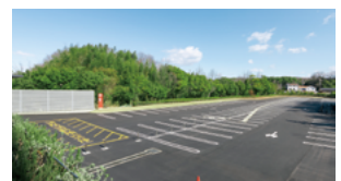
P2駐車場改修
