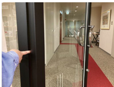
写真4 指を挟む恐れのある隙間
