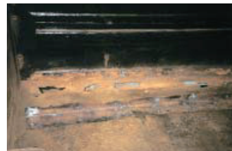
荷台フロア部は腐食による穴あき部分があり、 切断して現物合わせで鉄板から板金成形
