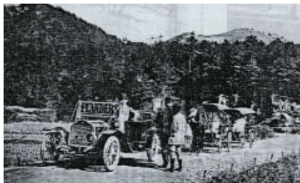
整備されている東海道
